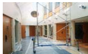
Travaux grande hauteur Calyon
