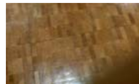
Remise en état du parquet en
